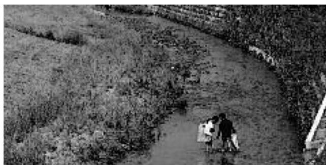
多自然型工法を用いた河川整備（谷地川）
