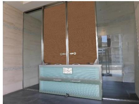
簡易脱着式止水板の場合
