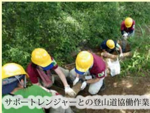
横断溝のメンテナンスをするレンジャー
