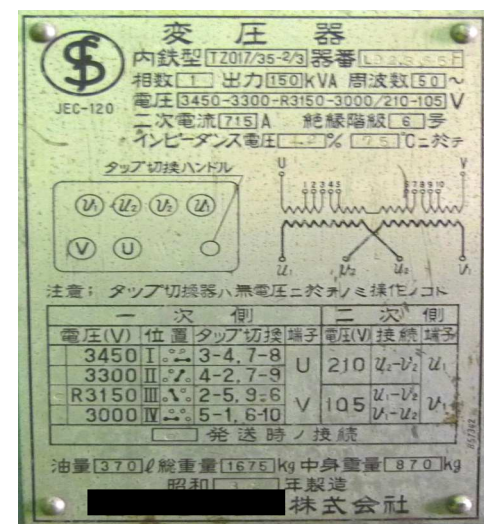
トランス(変圧器)の銘板
