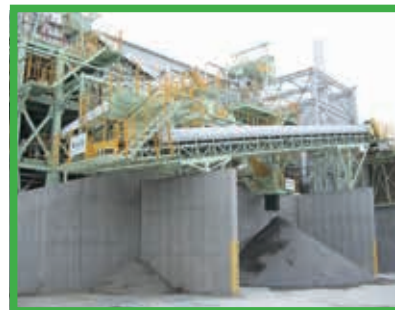
▲加熱すりもみライン
