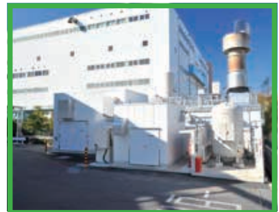
▲都市ガス製造供給設備
