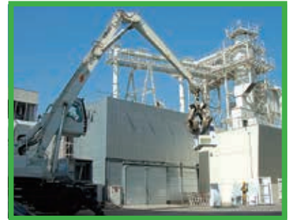
▲シュレッダー前の重機作業
