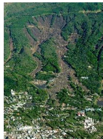
図0-1 大島土砂災害状況
