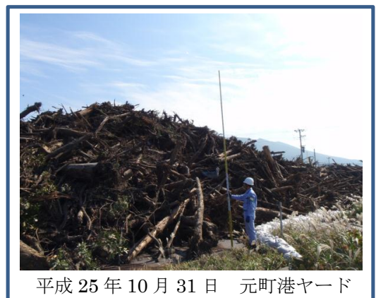
図1-4 一次仮置場の簡易測量風景
